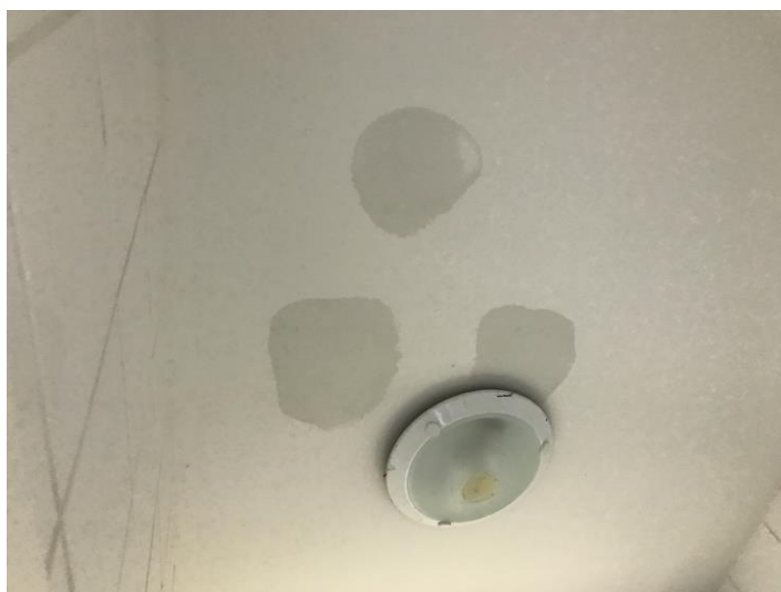
Imagem 22 – Pontos de infiltração
