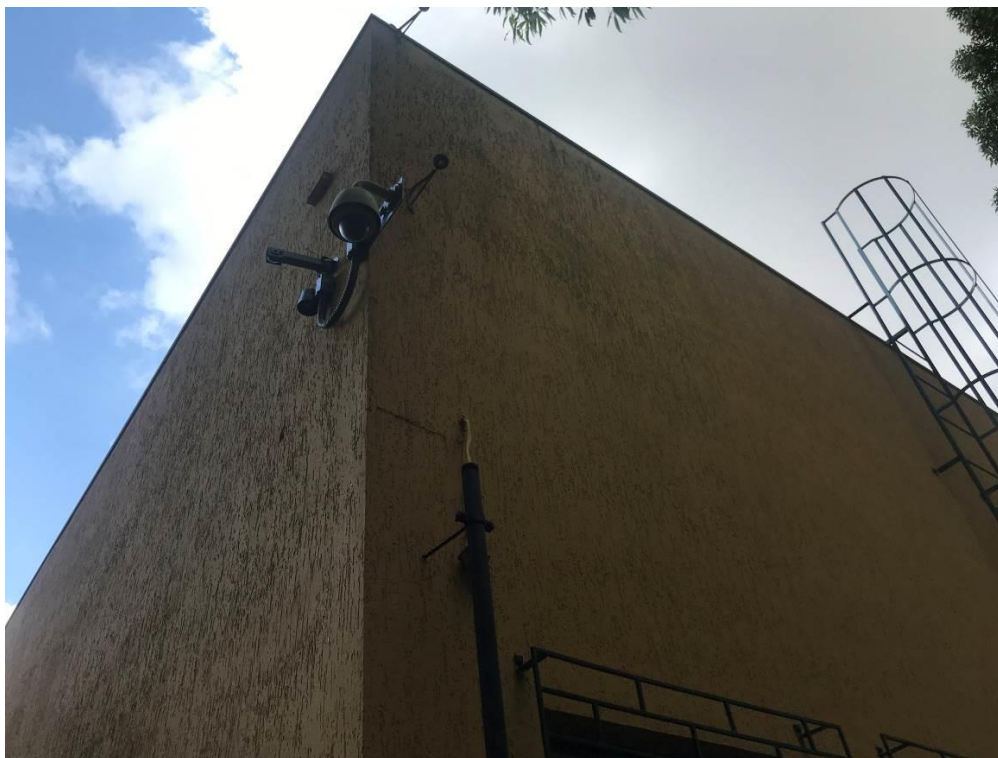
Imagem 39 – Descida SPDA sem cabo
