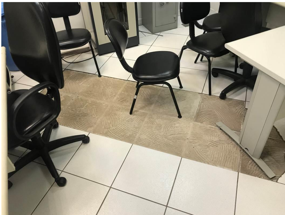
Imagem 31 – Piso cerâmico danificado
