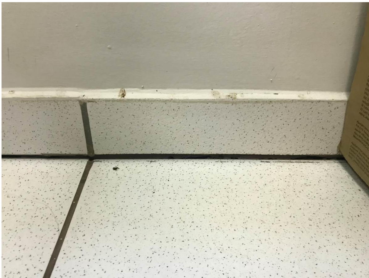
Imagem 32 – Recalque de assentamento
