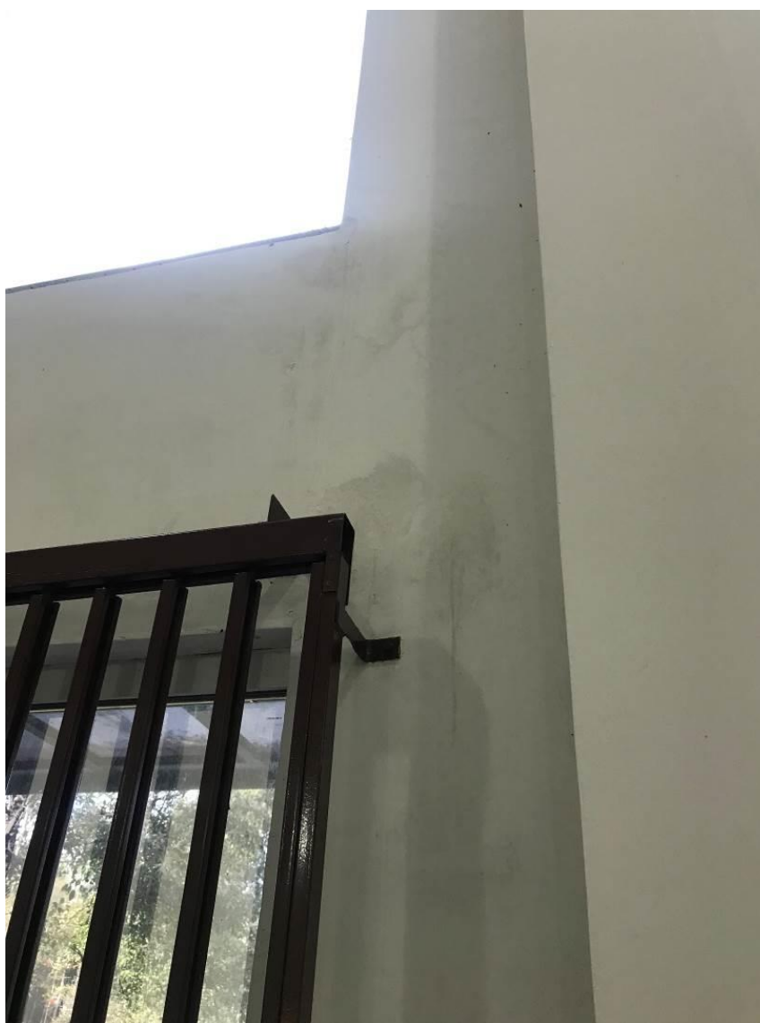
Imagem 28 – Infiltração C.A.E.
