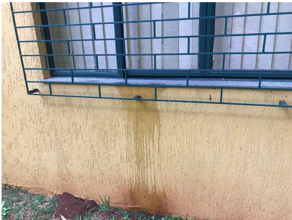
Imagem 25 – Parede Abaixo do dreno de ar condicionado
